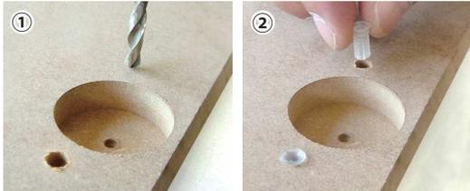
補修する丁番を取り外して、既存のビス穴を 5 mm 径のドリルで深さ 12 mm 以上の深さまであけ直し、アンカーをしっかりと挿し込みます。
